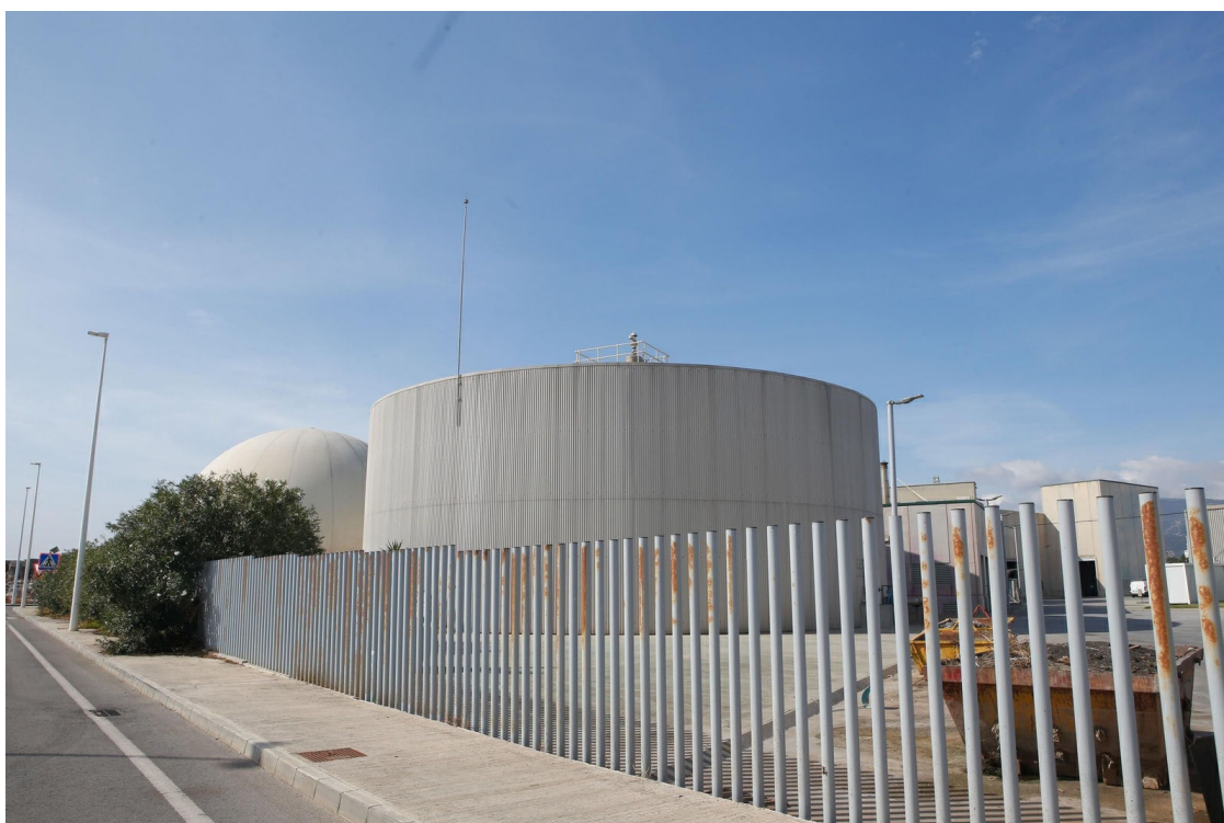
El exterior de la depuradora de Algeciras. / Vanessa Pérez
