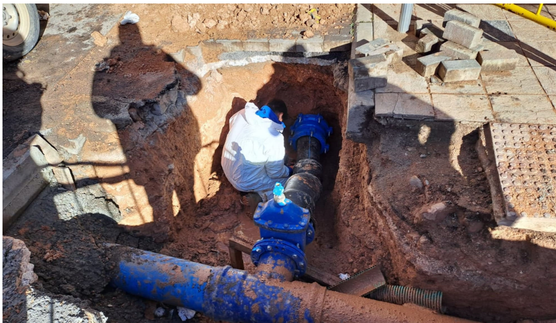
Detección y reducción de fugas de agua en Bolaños de Calatrava / Lanza
