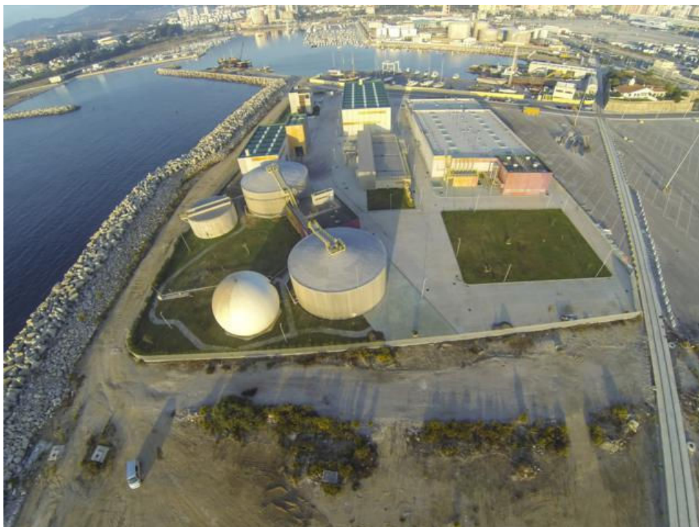
La EDAR de Algeciras. - A. I.
