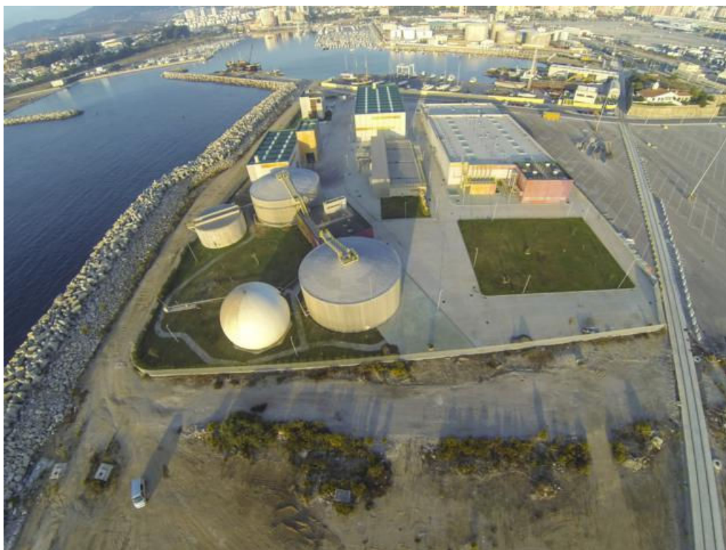
La EDAR de Algeciras. - A. I.
