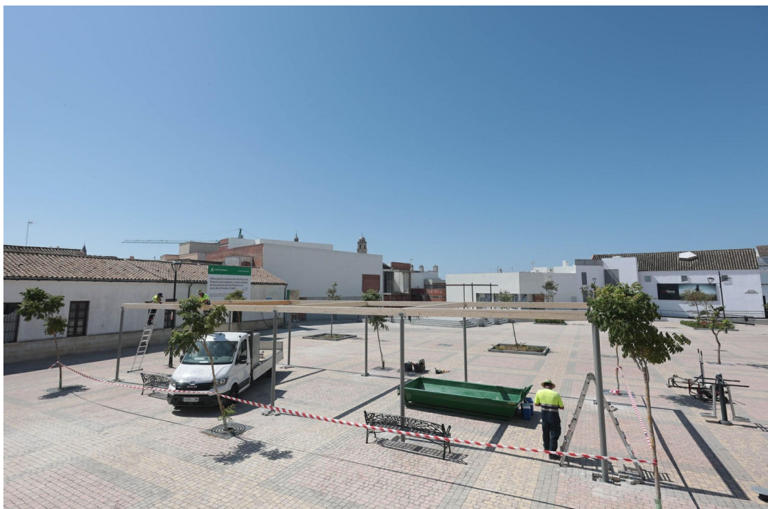
Obras de instalación de la nueva pérgola en la plaza Belén de Jerez
