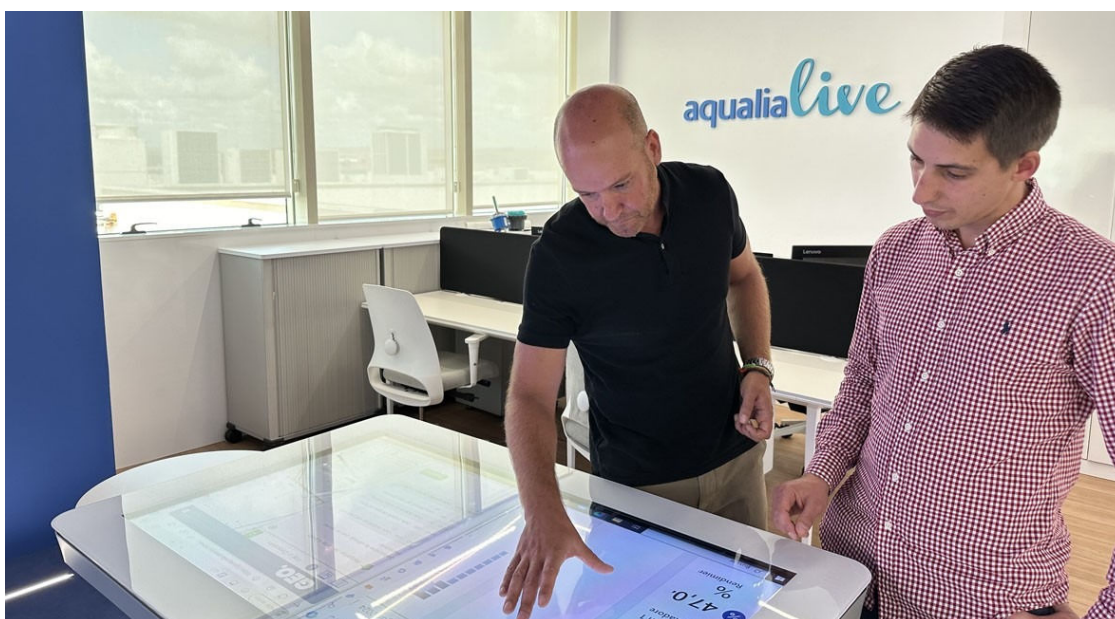
Uno de los Centros de Operaciones Integrados (COI) donde Aqualia recopila y analiza los datos de las redes de los municipios.
